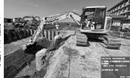
ICT建機による崩落斜面の土砂撤去
